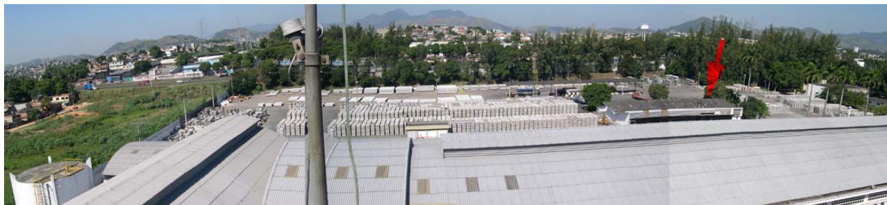
Foto 23 – Vista parcial da fábrica da Eternit Rio de Janeiro. Notar telhas pintadas no galpão principal da fábrica. A seta à esquerda indica o refeitório, com telhado mais escuro (telhas não pintadas).
