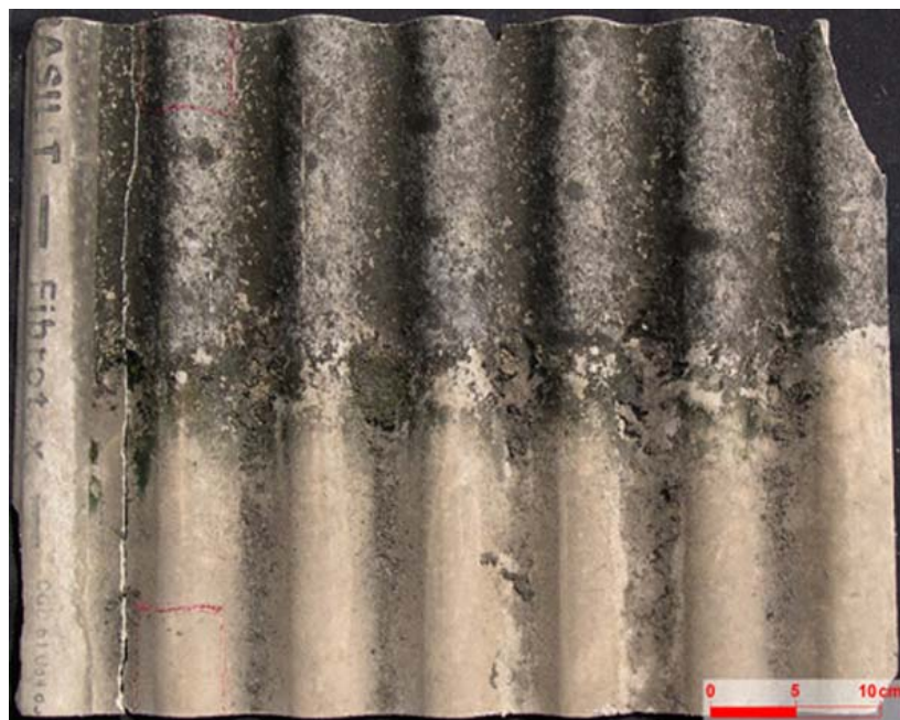
Foto 31 – Telha ondulada depósito Crespum (LPTR 690/05)
