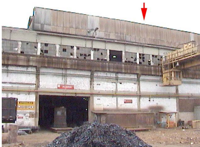
Foto 10 – Pavilhão da Aciaria, destacando-se o local de coleta da amostra de telha.
