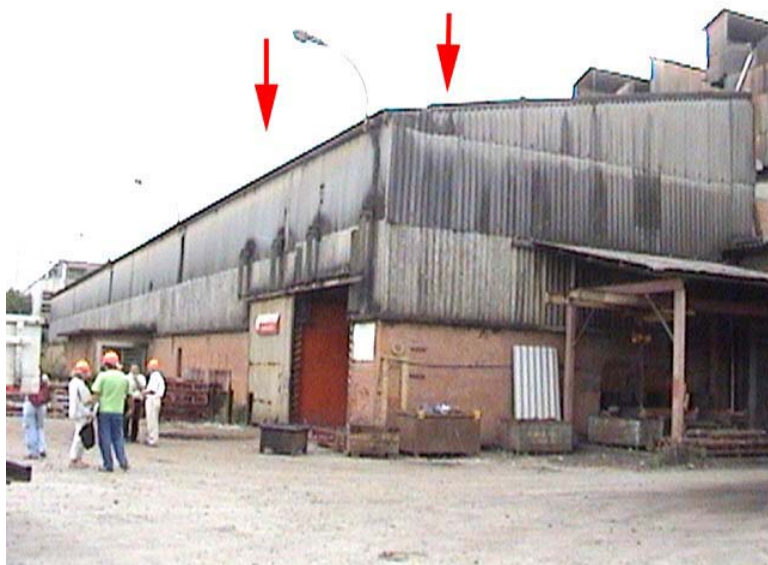
Foto 15 – Pavilhão da Fábrica de Eixos, destacando-se os locais aproximados de coleta das amostras de telhas.
