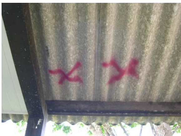
Foto 58 - Bloco PB Sala P1, na UFPA.
