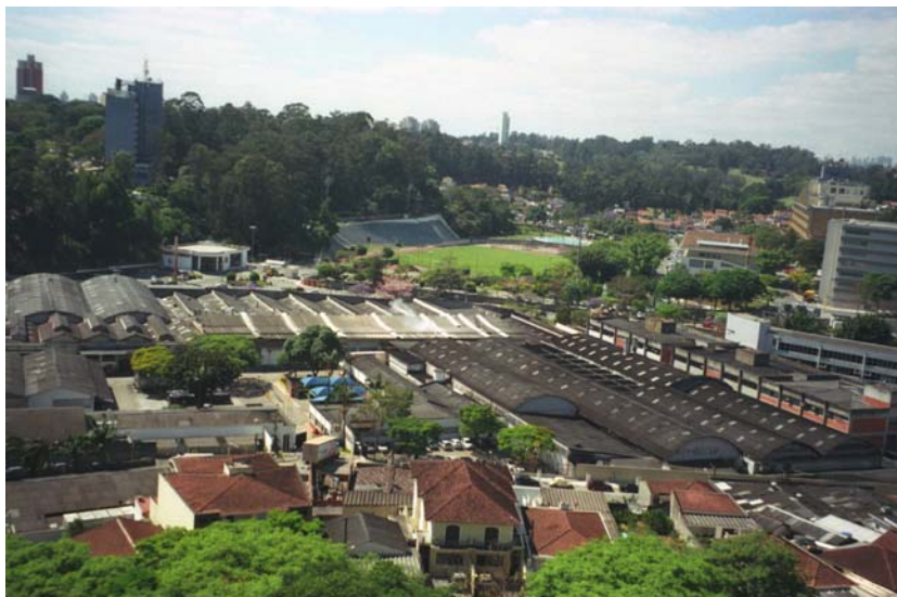
Foto 1 - Vista da região de Osasco. Destaca-se a indústria Adamas S.A., com cobertura de telhas de cimento-amianto.
