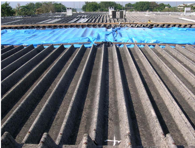
Foto 35 – Telhas tipo canaletão selecionada para amostragem (marcada com cruz branca).
