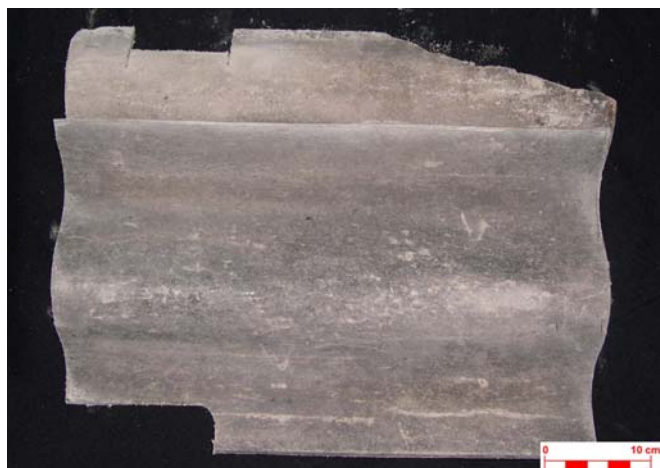
Foto 6 – Telha Am-1.2 (LPTR 321/05), amostrada no Galpão Proact.
