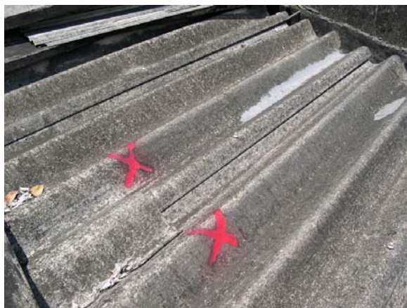
Foto 68 – Telhado do setor de carga e descarga do Banco do Brasil.
