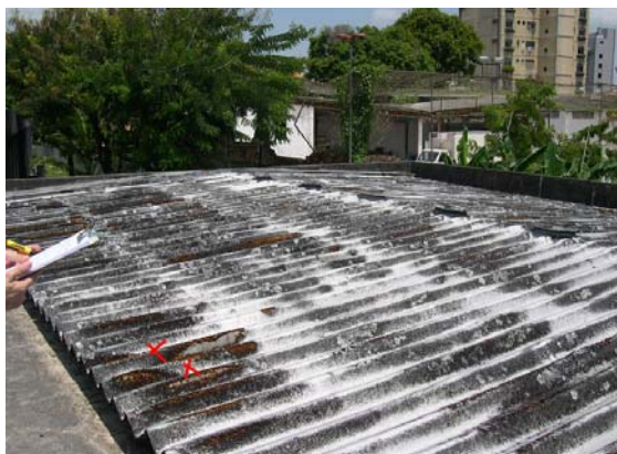
Foto 70 – Telhado do depósito do Banco do Brasil. A telha possui uma cobertura de espuma rígida com camada de tinta prateada.
