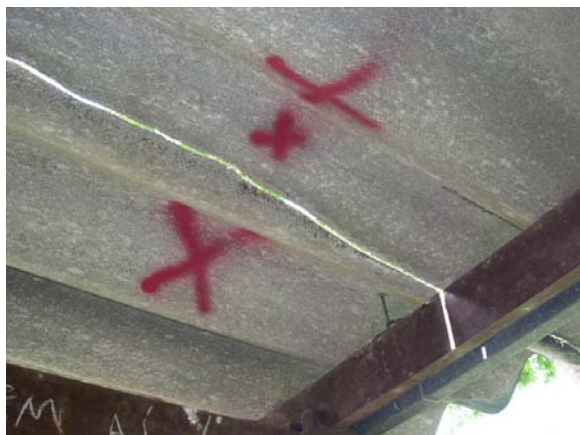
Foto 56 - Passarela PB blocos de salas de aula, na UFPA.
