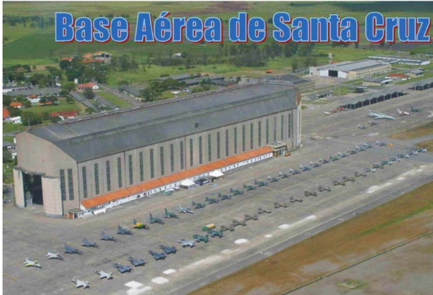
Foto 39 – Vista aérea do Hangar do Zeppelin, expondo a porta norte e o lado oeste.
