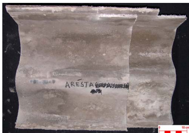
Foto 17 – Telha Am-5.2 (LPTR 326/05), amostrada na Fábrica de Eixos.
