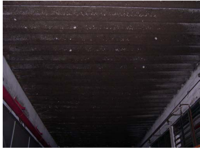
Foto 47 – Corredor interno do Pavilhão de recebimento. Os pontos brancos na telha correspondem provavelmente a material biológico.
